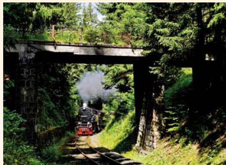
Im Kälberbruch bei Benneckenstein befindet sich ein Einschnitt mit einer maroden wirkenden Brücke, über die ein wenig genutzter Forstweg führt. Der 515 kW (700 PS) starken Dampflokomotive 99 7240 oblag am 11. Juli 2020 die Beförderung eines Sonderzugs über die Harzquerbahn nach Nordhausen. Foto: Dirk Bahnsen
